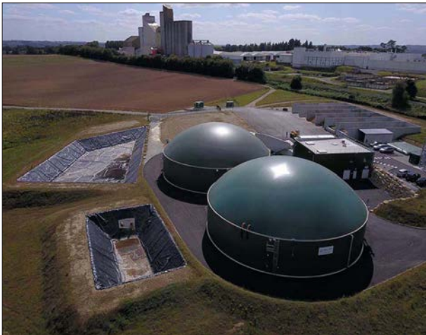
Récemment, le fabricant d'installations de biogaz WELTEC BIOPOWER a achevé la construction d'une usine de biométhane pour le producteur français de chips Bret's à Saint-Gérand, en Bretagne.
