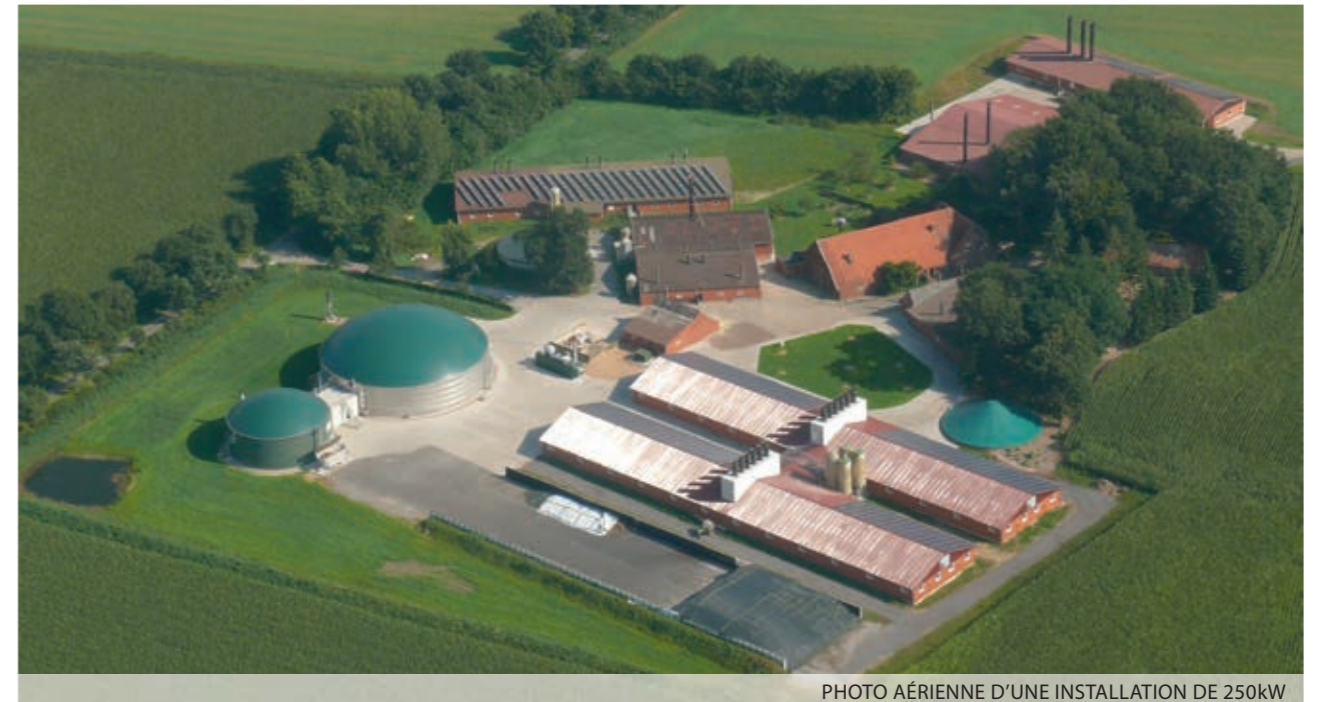
PHOTO AÉRIENNE D'UNE INSTALLATION DE 250KW
