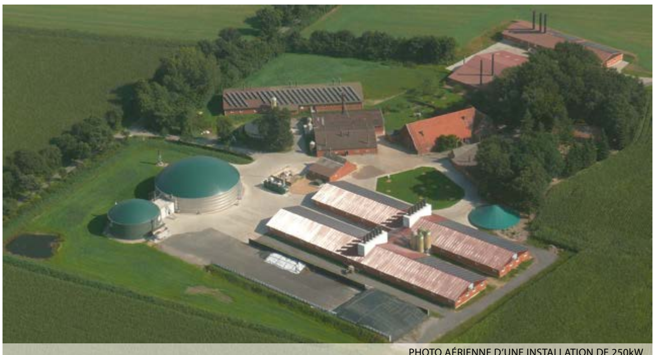
PHOTO AÉRIENNE D'UNE INSTALLATION DE 250KW
