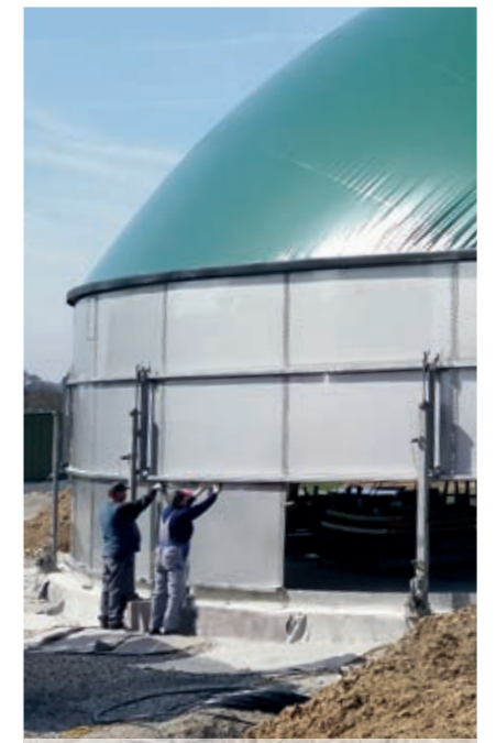
MONTAGE D'UNE CUVE
