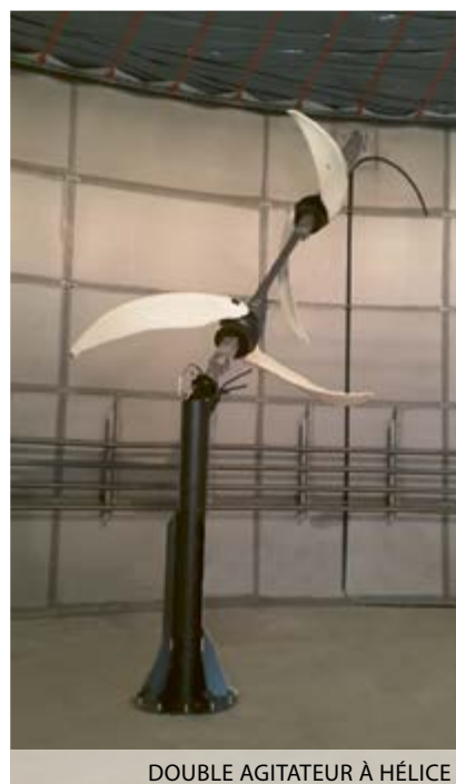
DIGESTEUR AVEC AGITATEUR AXIAL, VUE INTÉRIEURE
